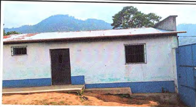
SUSTITUCION DE LAMINA POR DETERIORO
