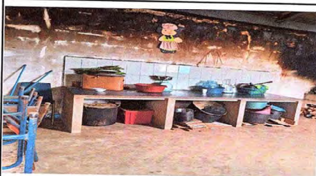
SUSTITUCIÓN PINTURA DE COCINA
