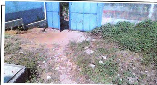
SUSTITUCIÓN PISO DE ENTRADA DE LA ESCUELA
