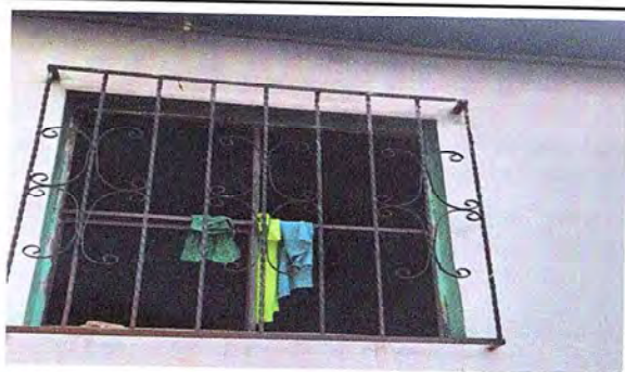
SUSTITUCION DE VENTANAS
